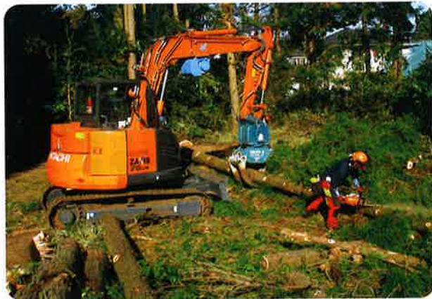
支障木伐採作業の様子
