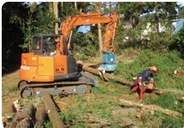
支障木伐採作業の様子
