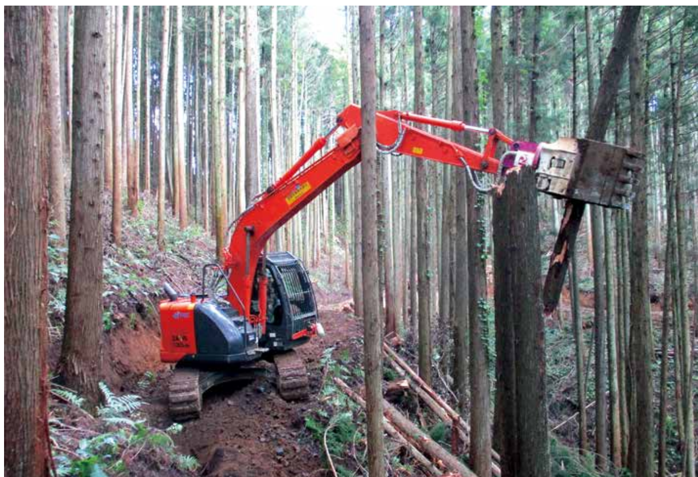
フェラーバンチャザウルスによる作業道開設の様子(城里町七会地内)
