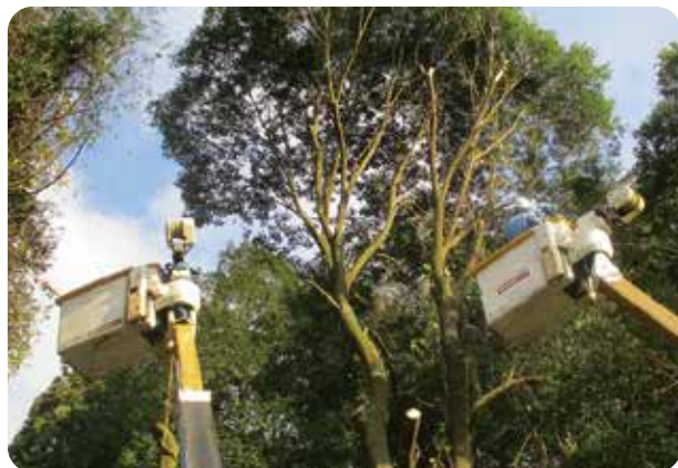
高所作業車を利用した作業
