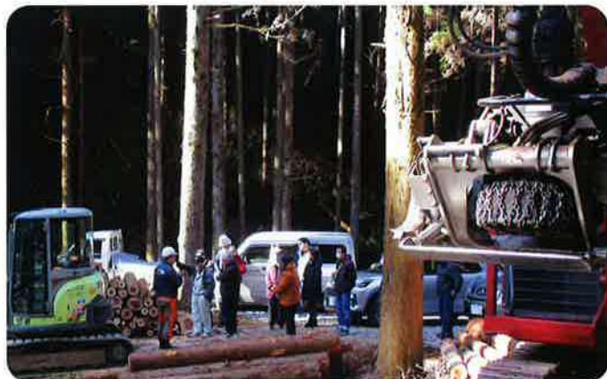
作業現場視察（七会地区）
