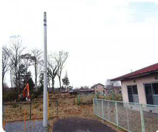
支障木伐採後
