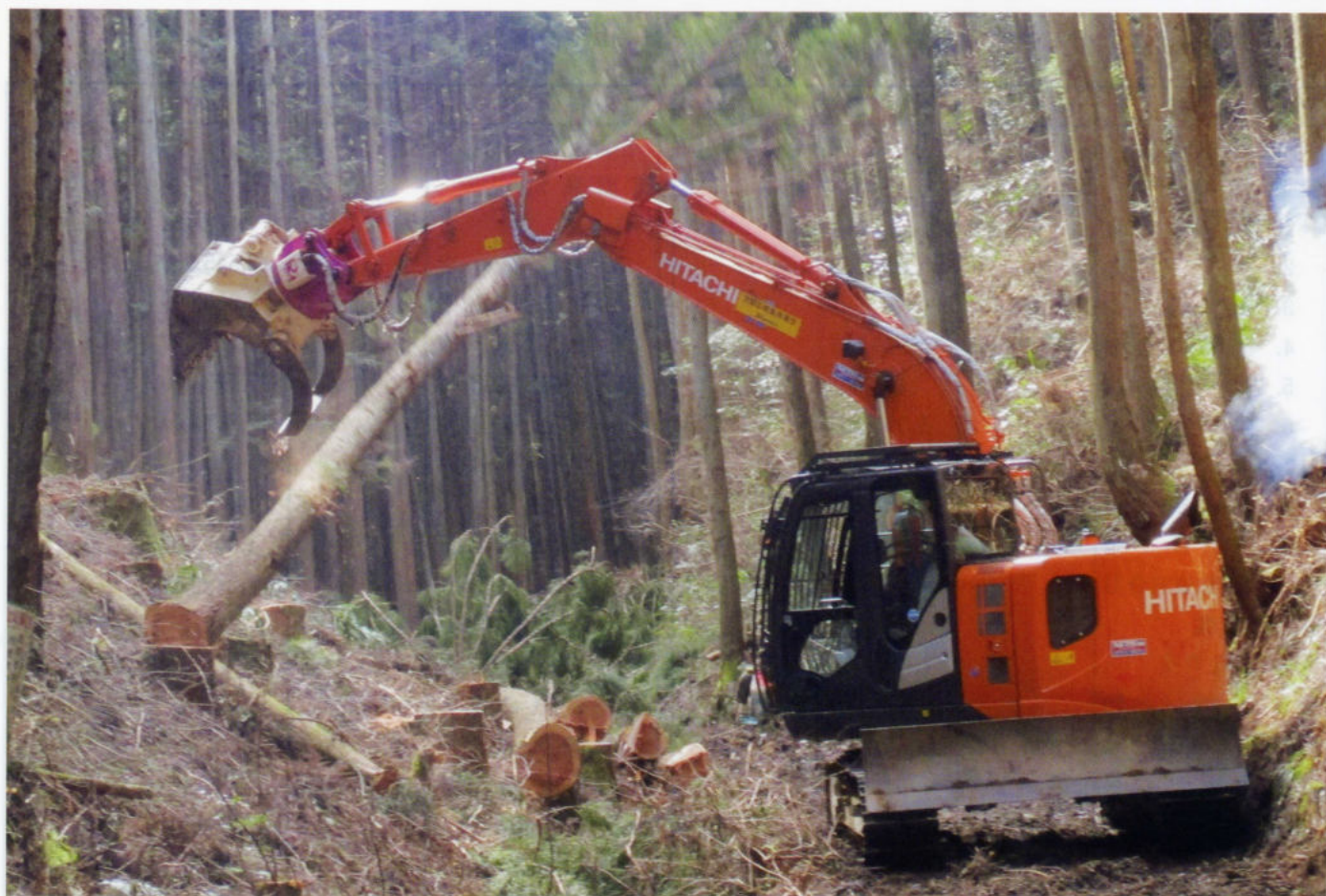
皆伐する山林への作業道開設(城里町塩子地内)
