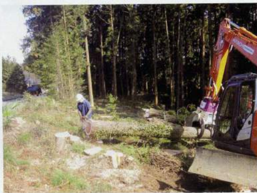
↑国道沿いの危険木伐採
