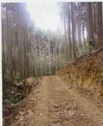
作業道の整備
