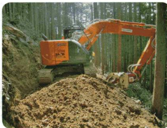
間伐材の搬出のための作業道を開設 (ザウルスロボ)
