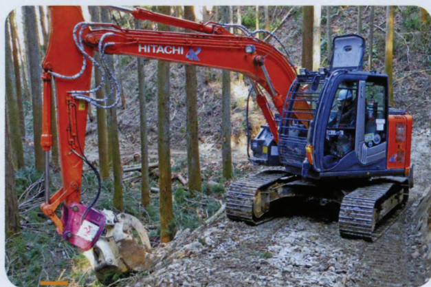
作業道の開設
