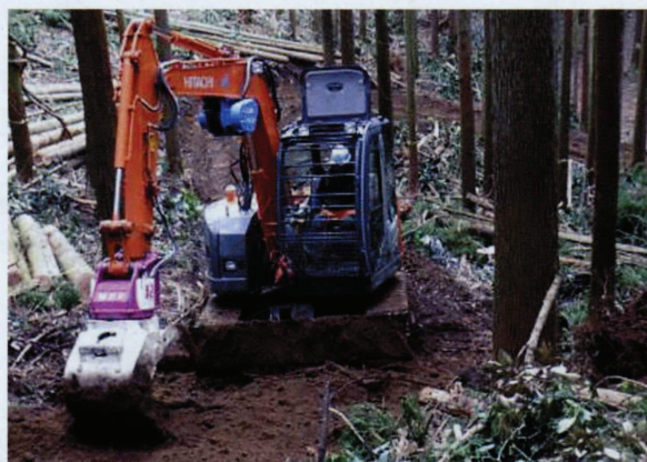
グラップル付きバックホウによる作業道開設
