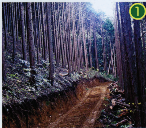
作業道の開設
